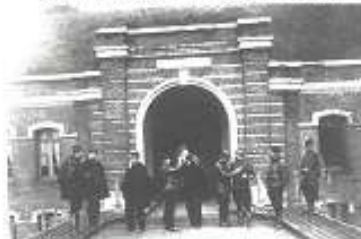
Entrée du Fort en 1902
